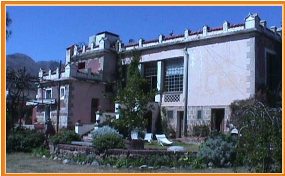
Contrafrente con vista al Norte. Nótese el desnivel del terreno que permitió varias dependencias en la planta baja o subsuelo de la casa. Desde allí se divisa el amplio jardín.
