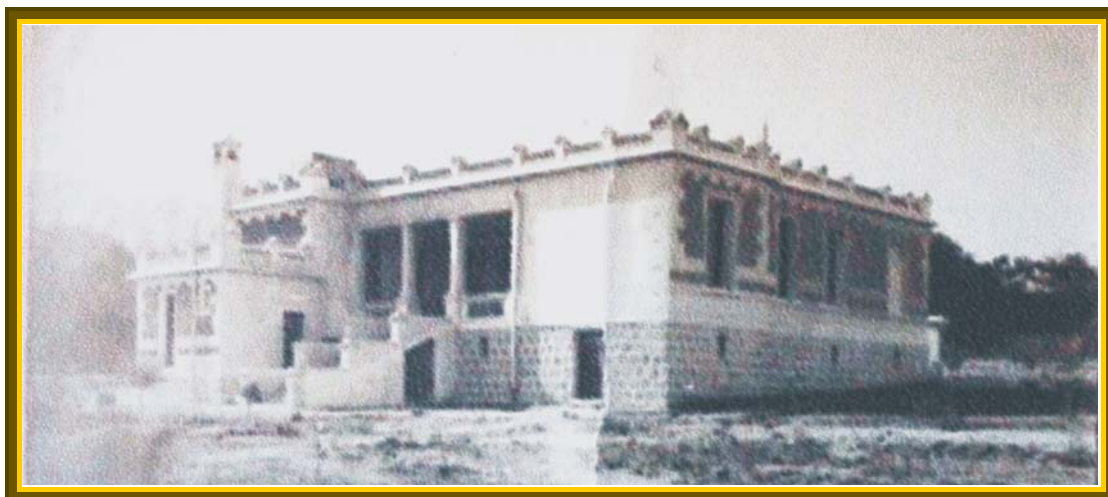
Año 1925 cuando la casa estaba casi terminada. Vista del contrafrente.
